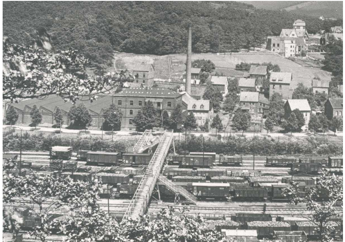
Fußgängerbrücke über den Rangierbahnhof (Fotoausschnitt)
